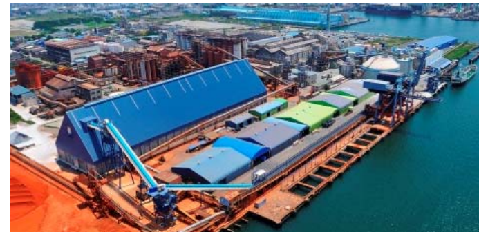
清水工場・輸入水酸化アルミ倉庫
