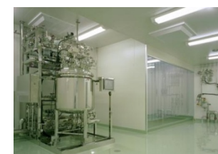
高気密パネルシステム (バイオ・クリーンルーム)
