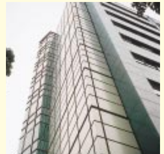
右の写真：ビル外装パネルへの施工例
